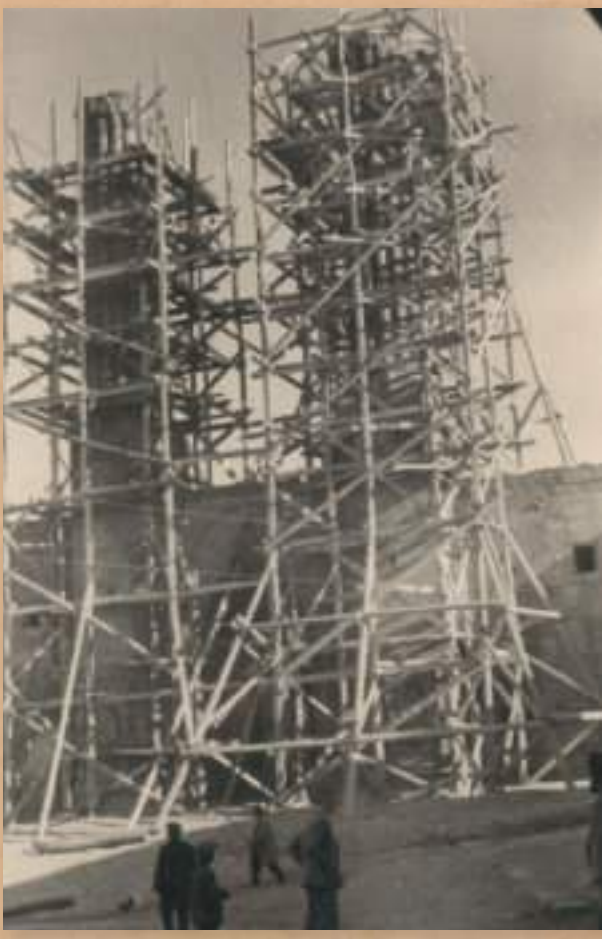
Medresenin Minarelerinin Onarımı (S.H.Eldem Arş)
