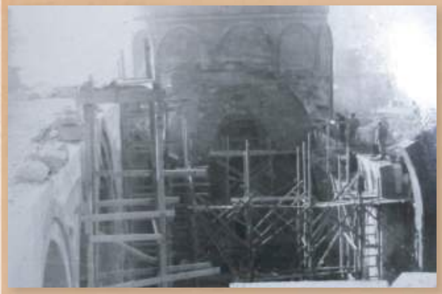
Çifte Minareli Medrese Ana Eyvan Tonoz Yapım Çalışması (1976)
