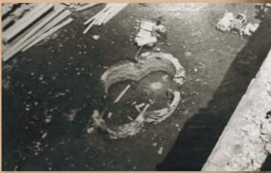
Çifte Minareli Medrese Ana Eyvan Tonoz Yapım Çalışması (1976)
