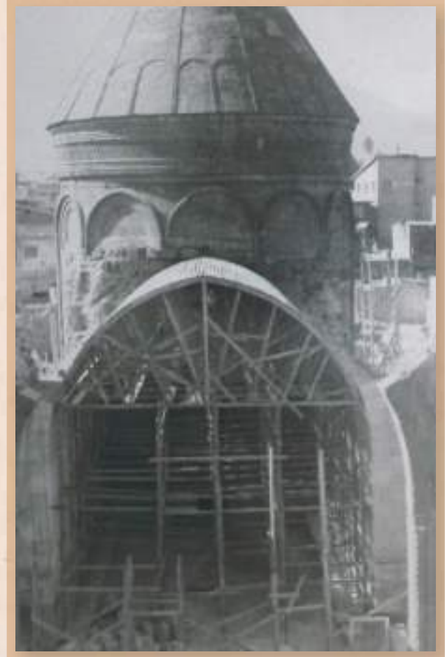
Çifte Minareli Medrese'nin Onarımı
